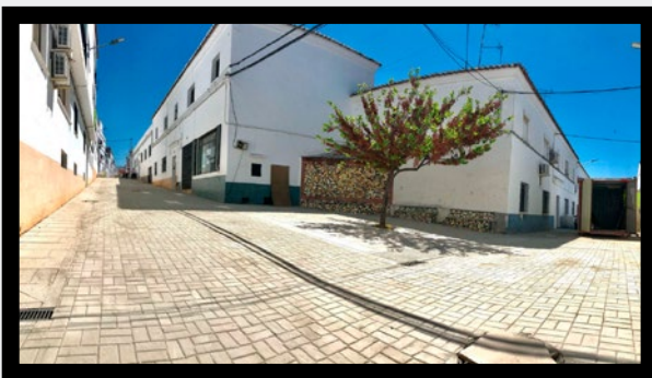
Adecuación del pavimento en el entorno del Parque
