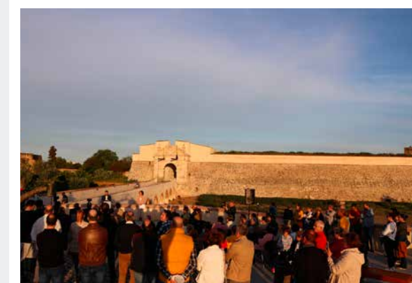
El objetivo principal de la rehabilitación de la Puerta del Calvario ha sido devolver el carácter monumental y defensivo de la Puerta, Muralla, Puente y Revellín.
