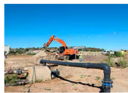
Las obras de las adecuaciones de las carreteras de San Francisco y San Rafael estarán concluidas a finales de año.
