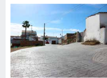
Mejora de la accesibilidad y conversión en plataformas únicas de varias calles de San Benito .
