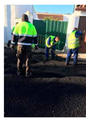
Primera fase del plan de asfaltado de las pedanías concluida.
