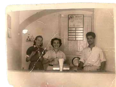
Comienzos de Los Valencianos, en la calle Moreno Nieto (baldosines)
