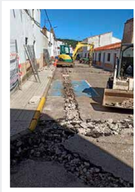
310 metros de tubería sustituidas para la renovación de toda la infraestructura hidráulica de abastecimiento en calle Obispo Amadeo en San Jorge de Alor .
