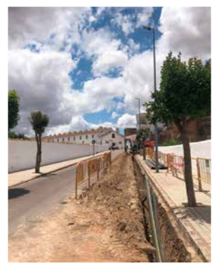
Aumentan las posibilidades de suministro energético en los hogares olivenzinos con la instalación, montaje, y puesta en marcha de la red de distribución de gas natural .
